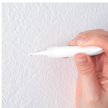
① 穴に補修パテを埋める。
