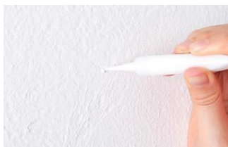
1：穴に補修パテを埋める。
